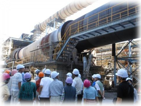
住友大阪セメント（バイオマス発電）
